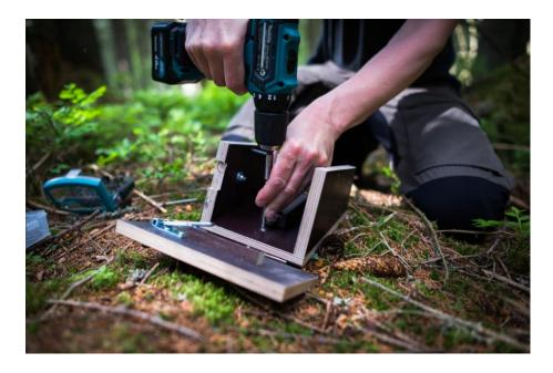
Ein Holz- oder Metallhäuschen schützt die Kamerafalle vor mechanischer Beschädigung bzw. starken Niederschlägen. Zusätzlich wird die Kamerafalle mit einem Stahlseil und Schloss vor Diebstahl geschützt.
