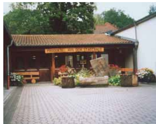
Betriebsgebäude des städtischen Forstamtes.
