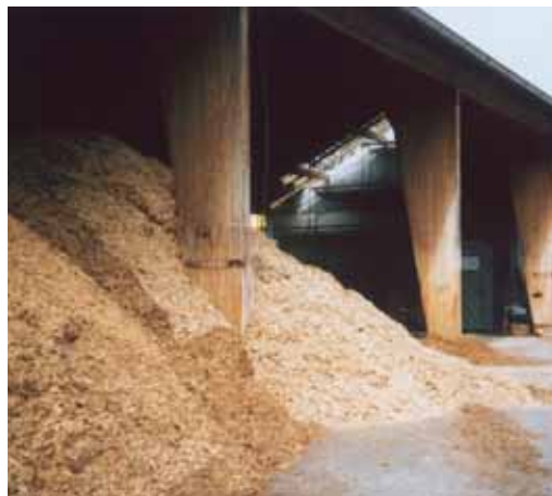
Das Hackschnitzellager für die neue Heizanlage.
