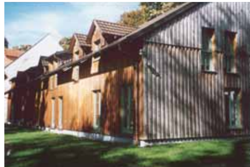
Das Wohn- und Bürogebäude wurde natürlich mit Holz aus dem eigenen Wald verschalt.
